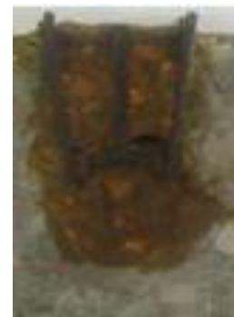
درز بین فاصله نگهدار و بتن
